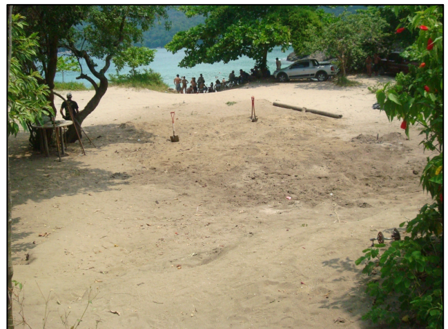
O mesmo local da foto acima, após a demolição.
