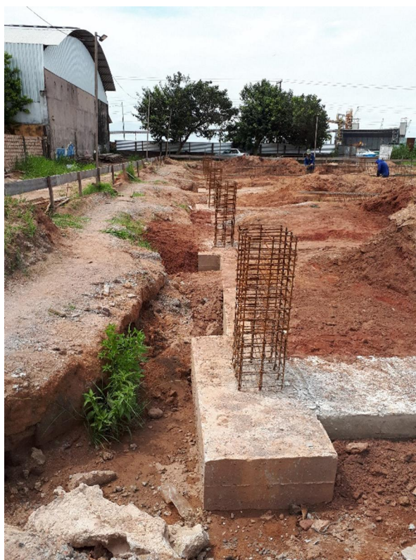
Figura 03: Instalação da ferragem da viga baldrame na obra da Gerência Regional Norte (GR01) em Santarém – PA. Março de 2020.
