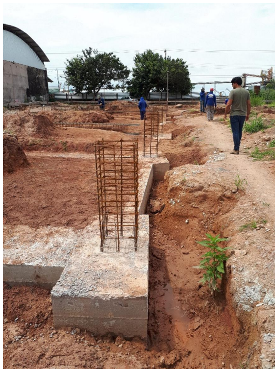
Figura 04: Instalação da ferragem da viga baldrame na obra da Gerência Regional Norte (GR01) em Santarém – PA. Março de 2020.
