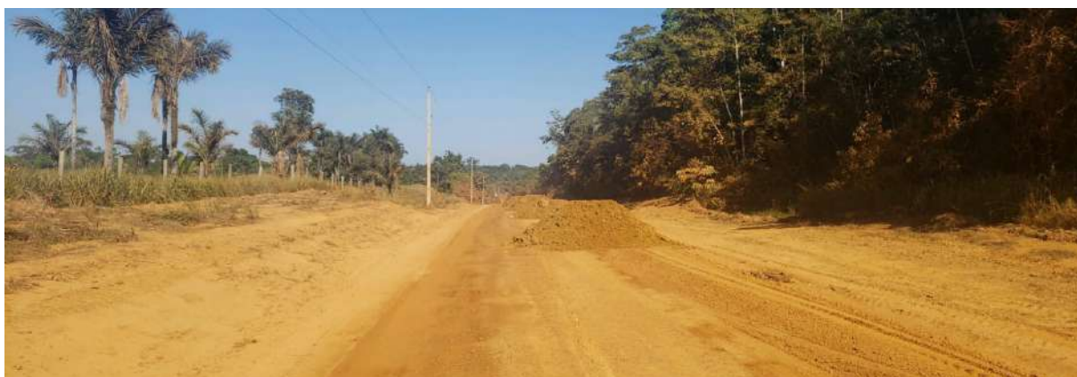
Foto 7. Levantamento Trecho da Transamazônica sob manutenção e recolocação de cascalho.
