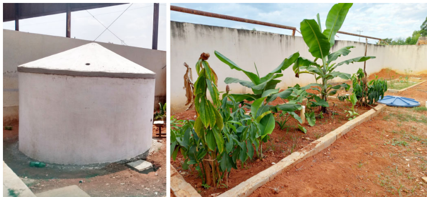
Figura 6. Imagens do sistema de captação de água da chuva em construção (à esquerda) e da fossa ecológica de evapotranspiração finalizada (à direita)
