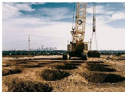
Figura 5.4: Atividade de compactação dinâmica do solo.
