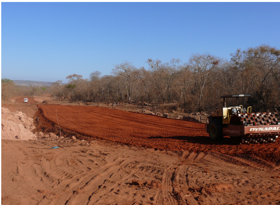
Figura 11 – Pavimentação para asfaltamento da BR-135, em São Desidério (BA). Dolinas e campos de lapiás foram destruídos exatamente sobre o maior sistema subterrâneo local Foto: Cristiano F. Ferreira
