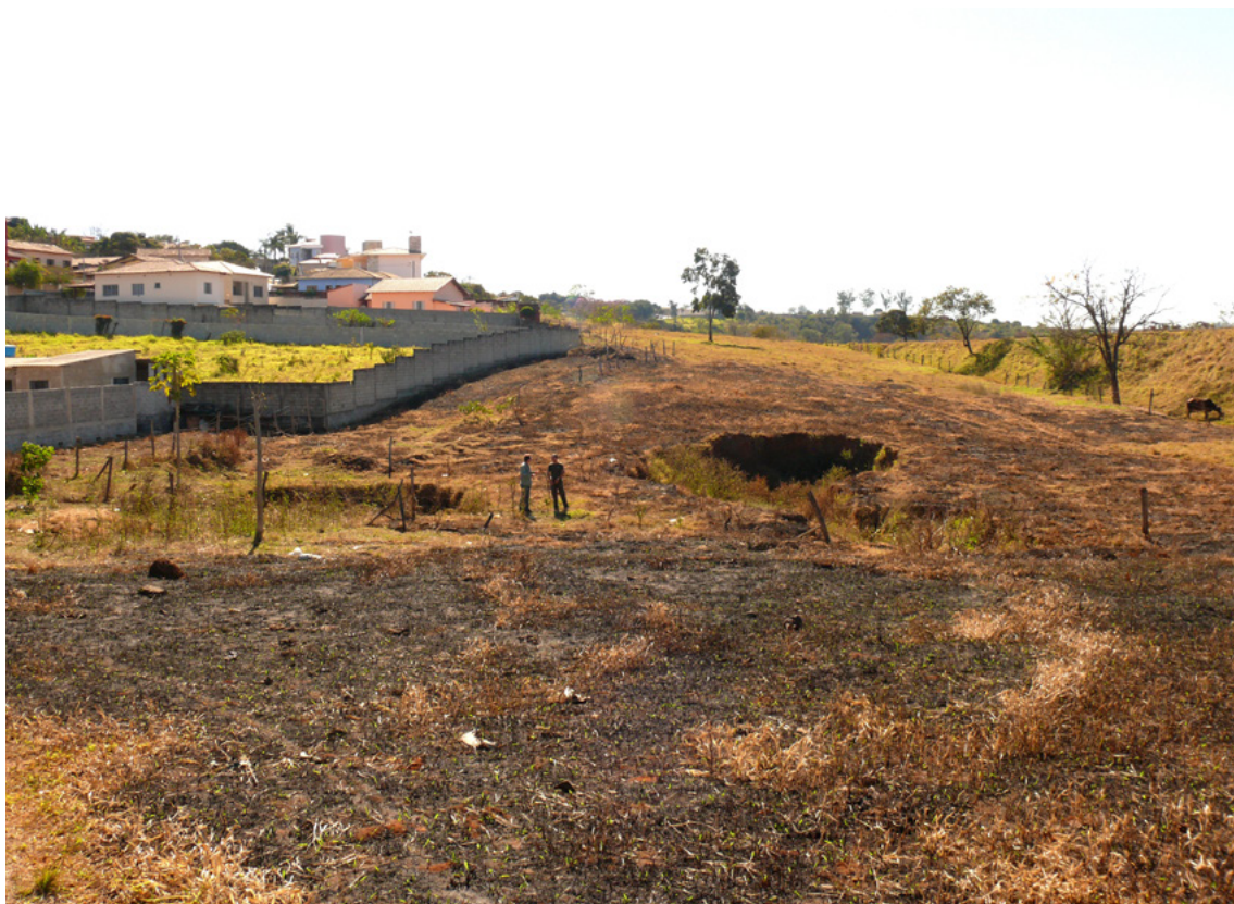
Figura 17 – Periferia de Matosinhos (MG), onde dois colapsos de cobertura próximos de casas denotam o risco da ocupação de áreas cársticas. Edificações na área já apresentam danos Foto: Cristiano F. Ferreira
