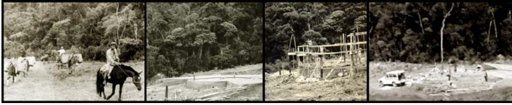
Figura 4 – Registros da década de 80, quando teve início a construção da sede da atual RPPN Mitra do Bispo.
