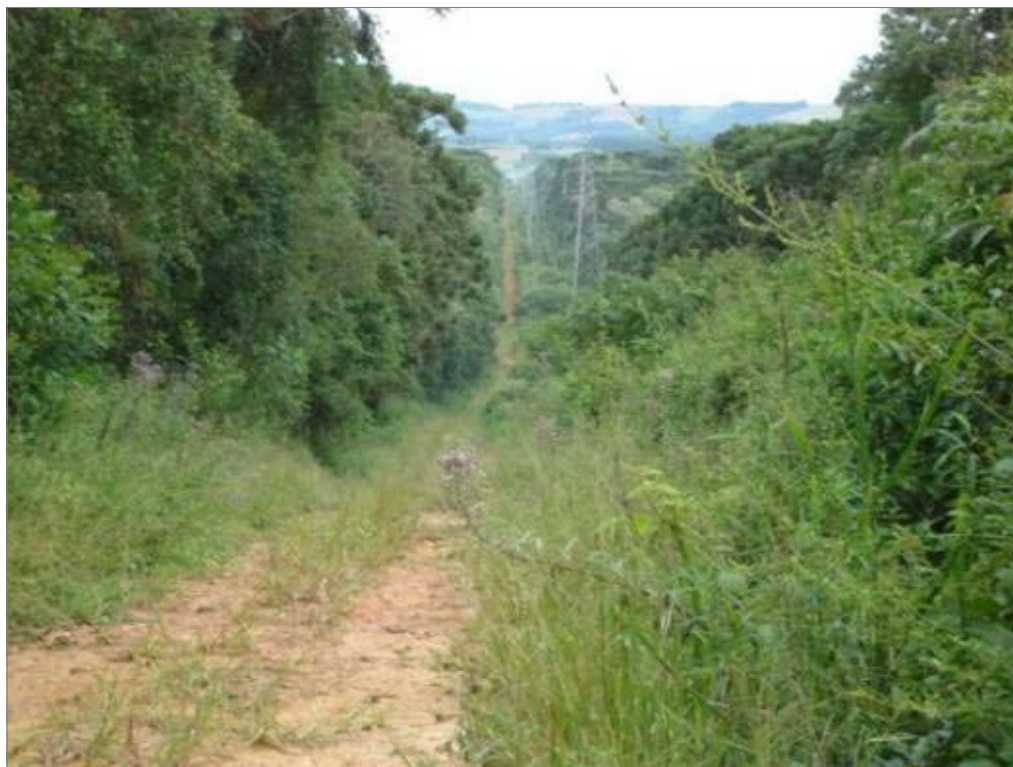
Figura 31. Linha de transmissão Irati-Sabará-Ponta Grossa.
