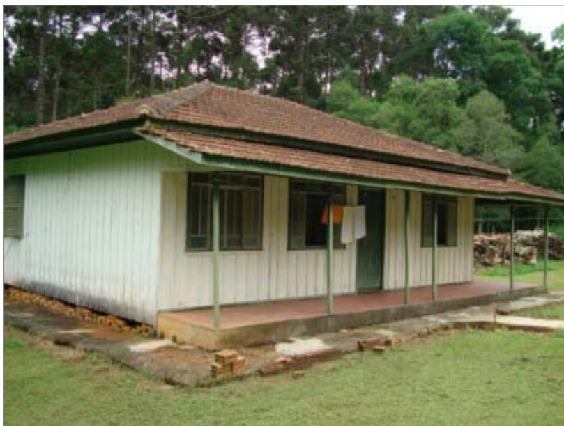
Figura 38. Edificação utilizada como refeitório, lavanderia e depósito.
