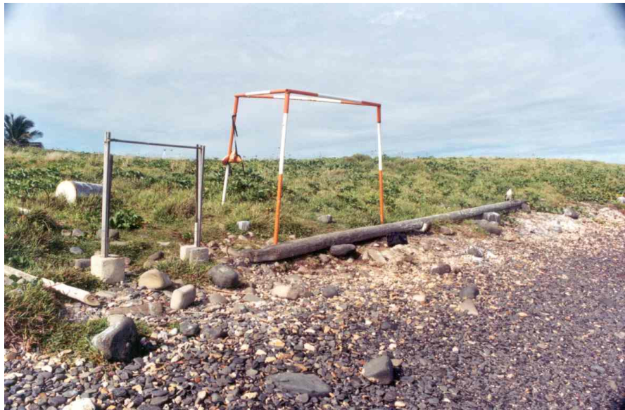
Foto 7 Estrutura de proteção dos guardas-parque para a recepção de visitantes na ilha Siriba.
