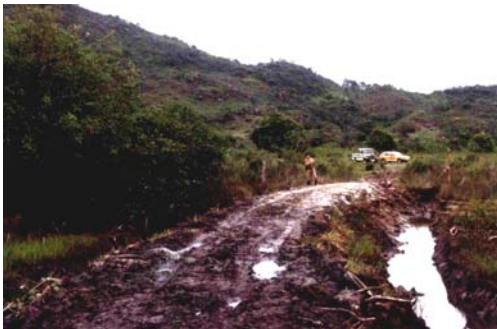
Fig.6.29: Acesso privado Sr. Estrella, na ocasião do embargo, em 1993
