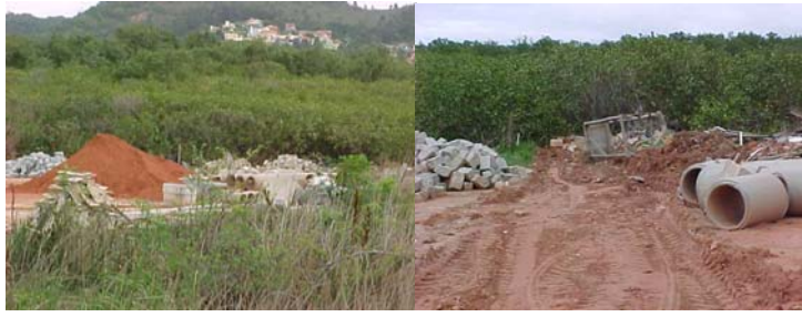
Fig. 6.15 e 6.16: Ausência de cercamento em áreas críticas
