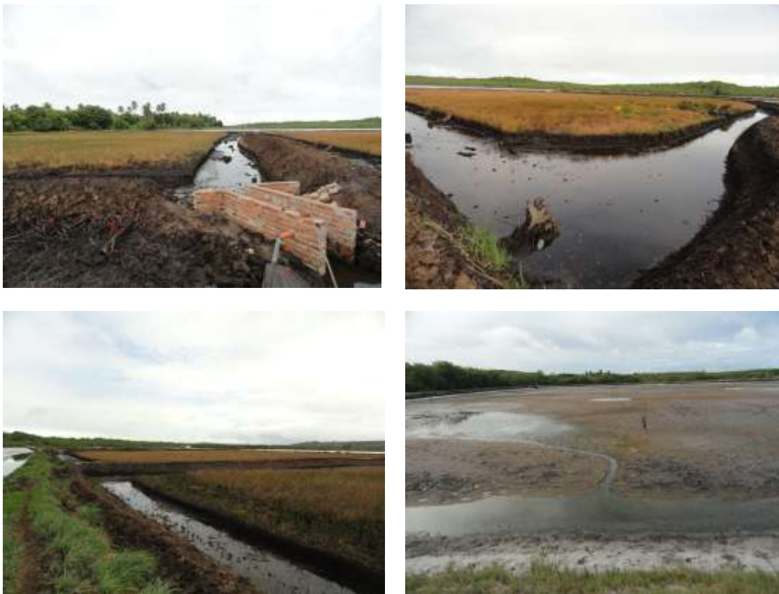
Figura 84 - Fase de construção de tanques de carcinicultura na região do Mamanguape.
