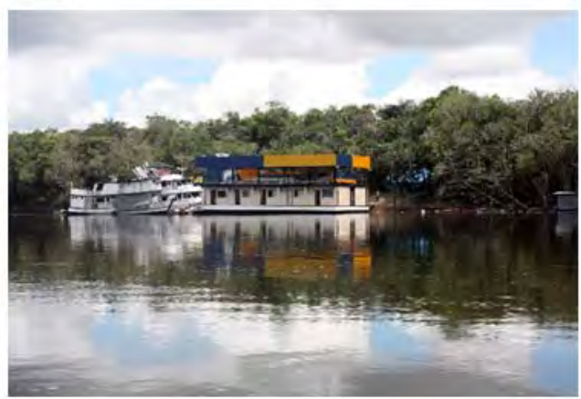
PortoTur (estrutura flutuante).
