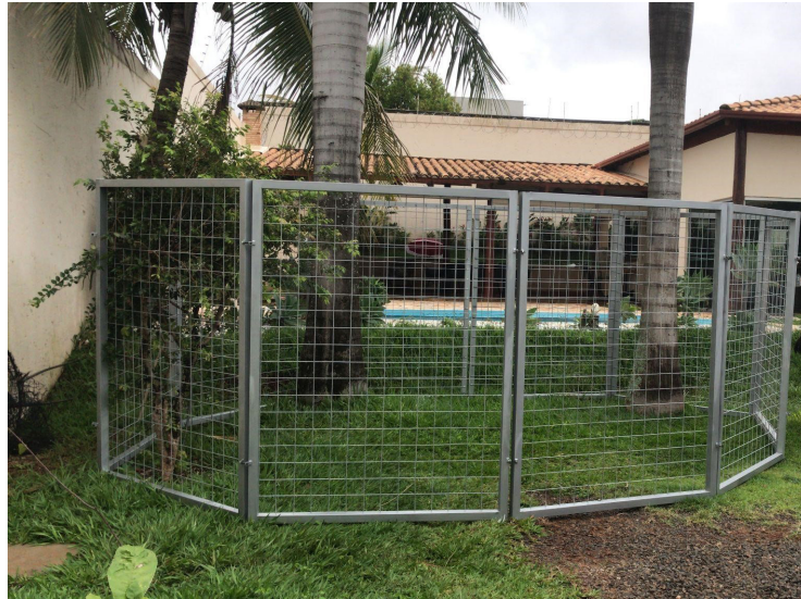
Fig. 13: Protótipo do recinto móvel do Projeto TamanduASAS. Esta estrutura possui 10 placas de metalon, dispostas em forma de círculo, com um espaço interno aproximado de 25 m 2 .
