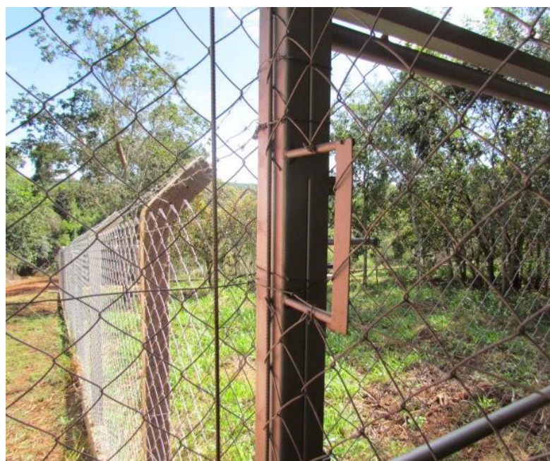
Fig. 4: Detalhes da Área do orifício retangular metálico que possibilita que o portão de acesso ao recinto seja aberto com o auxílio de um gancho de metal, pela área de segurança.
