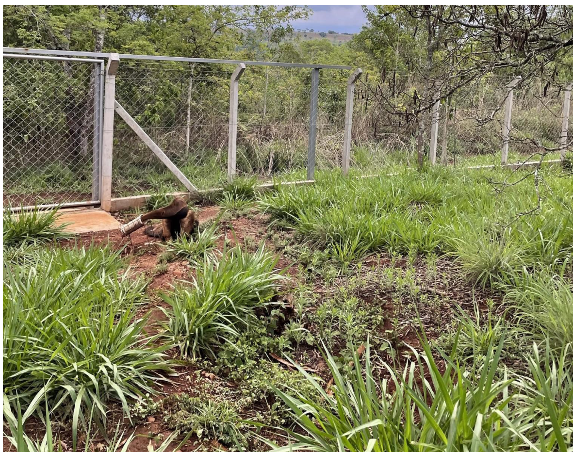
Fig. 8: Alambrado do recinto de reabilitação dos tamanduás-bandeira na RPPN Jacob com inclinação interna de 45 graus, no intuito de evitar fugas.
