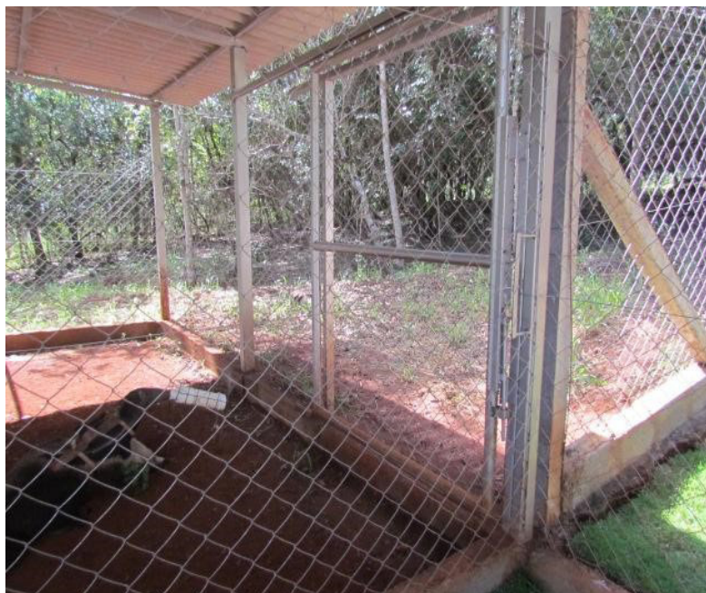
Fig. 3: Área de cambeamento com orifício retangular metálico que possibilita que o portão de acesso ao recinto seja aberto com o auxílio de um gancho de metal, pela área de segurança. Desta maneira, o tratador não tem contato com o animal.
