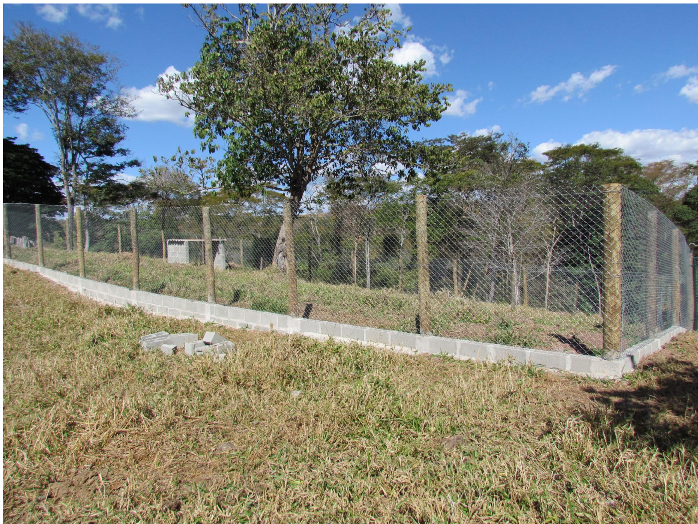
Fig. 1: Recinto de reabilitação de tamanduás-bandeira com área de 300 m 2 . Reparar na tela fixada em blocos de alvenaria.
