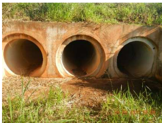
FIGURA 4. (ID-22) Passagem Inferior do tipo BDTC no KM 37+300. Coordenadas 22K 346541 7593315.
