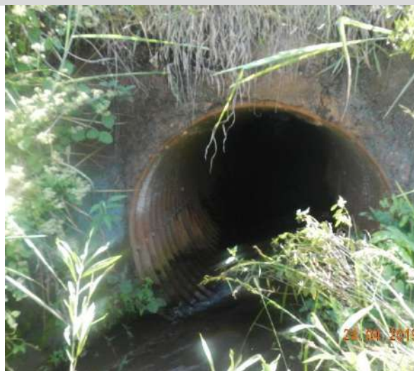
FIGURA 1. (ID-02) Passagem Inferior do tipo BSTM no KM 71+000. Coordenadas 22K 316620 7581525.
