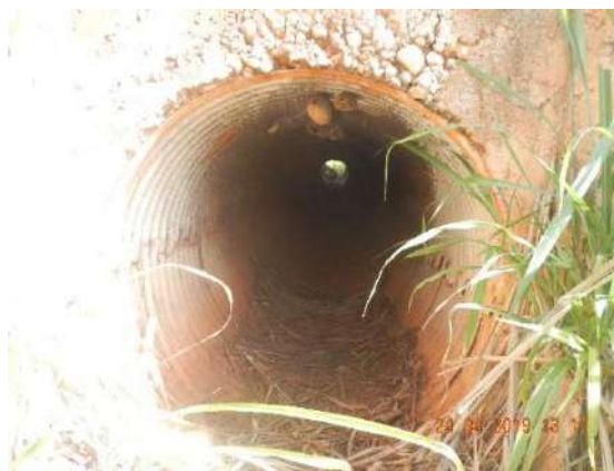
FIGURA 14. (ID-12) Passagem Inferior do tipo BSTC no KM 114+900. Coordenadas 22K 275461 7588807.
