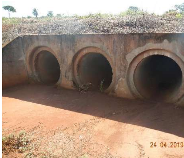
FIGURA 6. (ID-04) Passagem Inferior do tipo BTTC no KM 84+900. Coordenadas 22K 303167 7580061.
