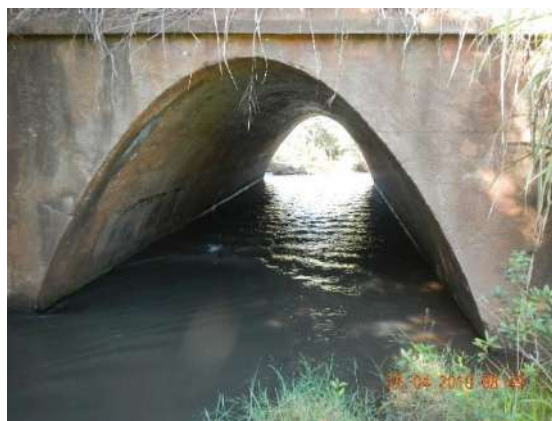
FIGURA 32. (ID-30) Passagem Inferior do tipo GALERIA no KM 245+200. Coordenadas 21K 774533 7622392.
