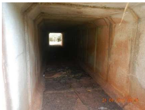
FIGURA 5. (ID-24) Passagem Inferior do tipo BSCC no KM 44+900. Coordenadas 22K 341874 7587718.
