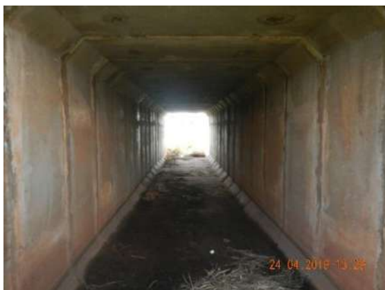
FIGURA 15. (ID-13) Passagem Inferior do tipo BSCC no KM 121+700. Coordenadas 22K 269294 7591973.
