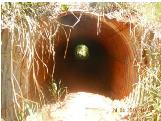
FIGURA 9. (ID-07) Passagem inferior do tipo BSTM na BR-267 no KM 96+200. Coordenadas 22K 291958 7581619.
