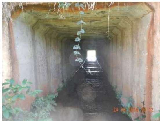
FIGURA 7. (ID-26) Passagem Inferior do tipo BSCC no KM 55+050. Coordenadas 22K 332040 7585056.
