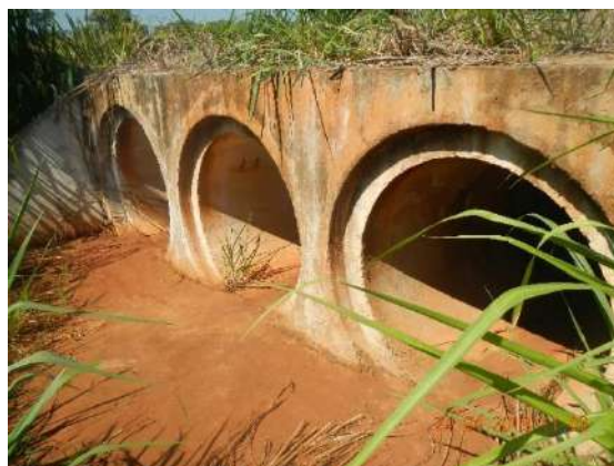
FIGURA 8. (ID-06) Passagem Inferior do tipo BTCC no KM 90+100. Coordenadas 22K 297996 7581193.
