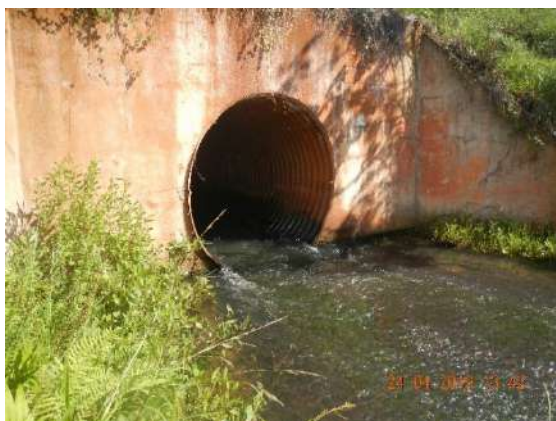
FIGURA 17. (ID-15) Passagem Inferior do tipo BSTM no KM 123+200. Coordenadas 22K 267855 7592257.
