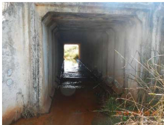
FIGURA 30. (ID-28) Passagem Inferior do tipo BSCC no KM 60+000. Coordenadas 22K 327114 7583930.
