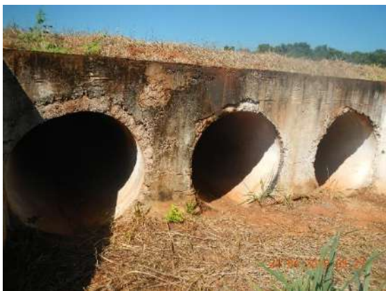
FIGURA 8. (ID-27) Passagem Inferior do tipo BTTC no KM 56+100. Coordenadas 22K 330929 7584799.
