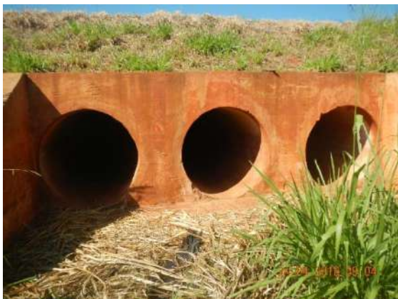
FIGURA 6. (ID-25) Passagem Inferior do tipo BTTC no KM 52+400. Coordenadas 22K 334621 7585637.
