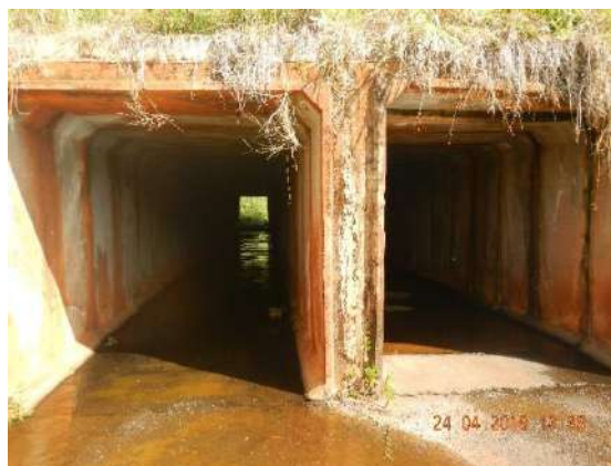
FIGURA 16. (ID-14) Passagem Inferior do tipo BTCC no KM 123+200. Coordenadas 22K 267855 7592257.
