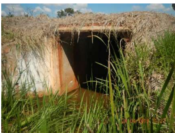
FIGURA 11. (ID-09) Passagem Inferior do tipo BSCC no KM 99+200. Coordenadas 22K 289185 7582317.
