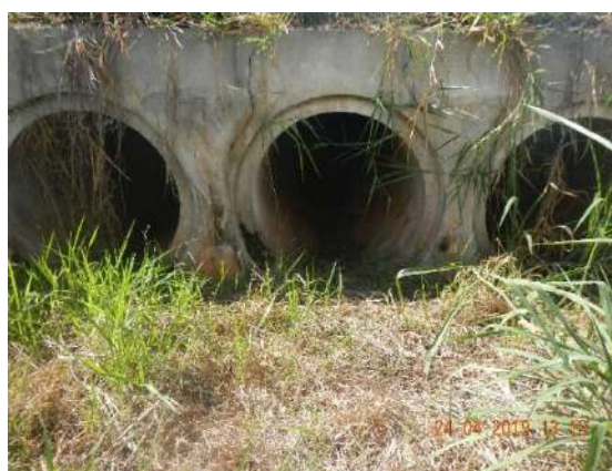
FIGURA 12. (ID-10) Passagem Inferior do tipo BSCC no KM 113+400. Coordenadas 22K 289185 7582317.
