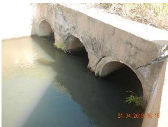
FIGURA 25. (ID-23) Passagem Inferior do tipo BTTC no KM 39+900. Coordenadas 22K 344785 7591641.
