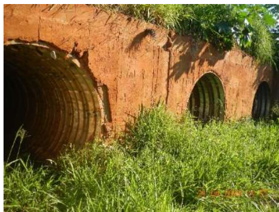
FIGURA 20. (ID 18) Passagem Inferior do tipo BTTC no KM 153+000. Coordenadas 22K 240506 7604928.
