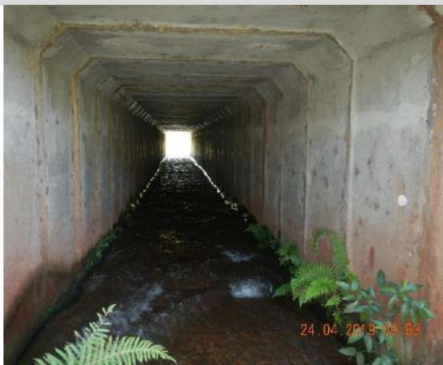
FIGURA 3. (ID-01) Passagem Inferior do tipo BSCC no KM 63+600. Coordenadas 22K 323679 7583148.
