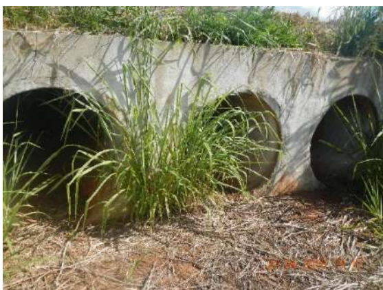
FIGURA 13. (ID-11) Passagem Inferior do tipo BTTC no KM 114+900. Coordenadas 22K 275461 7588807.
