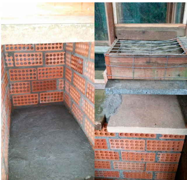
Figura 14 – Estrutura para comportar aquecedor a óleo para dois cambeamentos vizinhos, Mantenedor de Fauna Arca de Noé, Morro Reuter/RS. Fotos: Moira Ansolch.
