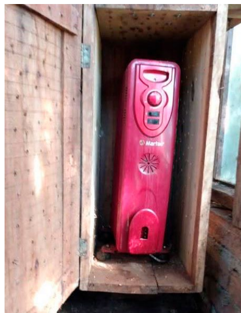
Figura 15 – Aquecedor a óleo protegido por caixa de madeira com aberturas, Mantenedor de Fauna Arca de Noé, Morro Reuter/RS. Foto: Moira Ansolch.
