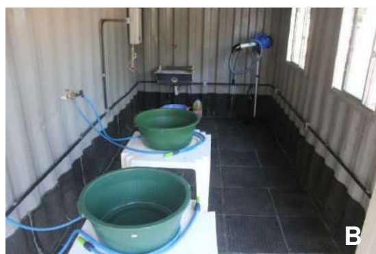
Figura III.3.4-3 – Área interna dos contêineres. A) Container ambulatório com mesa de procedimento em aço inox e suportes para soro. B) Contêiner de lavagem com sistema de aquecimento de água pressurizado (2 saídas de água), água fria (2 saídas) e secador do tipo pet.
