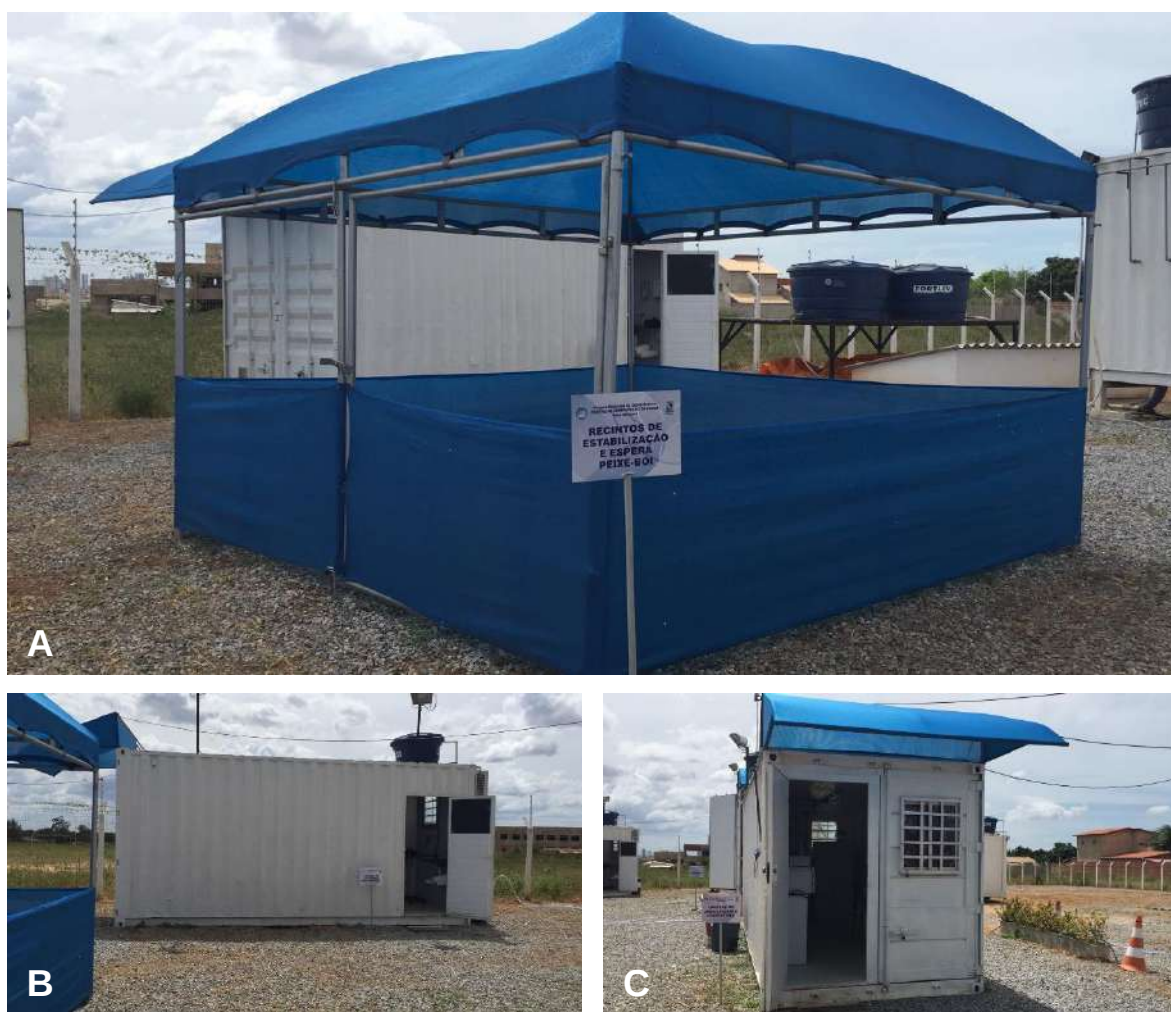
Figura III.3.3-1 – Estrutura para atendimento à fauna marinha oleada. A) Recinto de estabilização de peixe-boi; B) Contêiner de secagem e Recuperação e C) Contêiner de ambulatório de laboratório.
