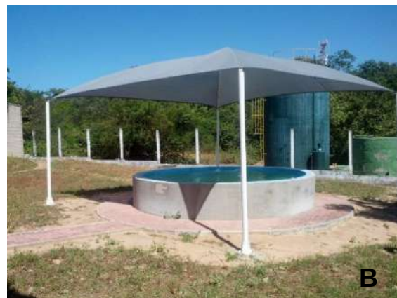
Figura III.3.4-4 – Recintos destinados a atendimento de fauna oleada. A) Recinto telado para aves, com antessala para evitar fuga de animais e piscina de baixa profundidade (alimentada com água doce ou salgada). B) Recinto (29,4m²) isolado dedicado a estabilização e tratamento de peixes-bois oleados, abastecido com água salgada tratada.
