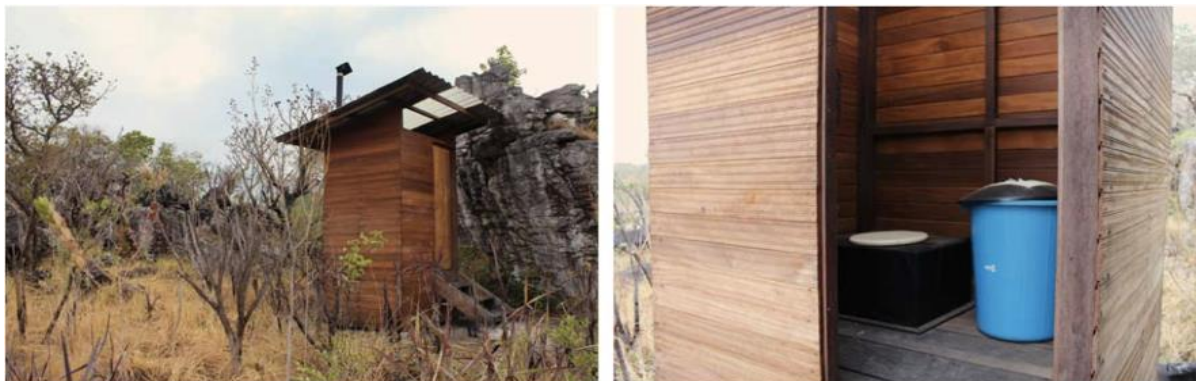
Figura 14: Banheiro seco da trilha das Sete Quedas
