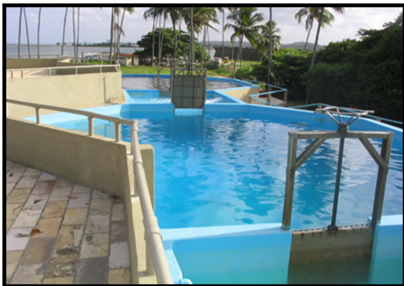
FIGURA 1 – VISTA DOS OCEANÁRIOS DE VISITAÇÃO.
