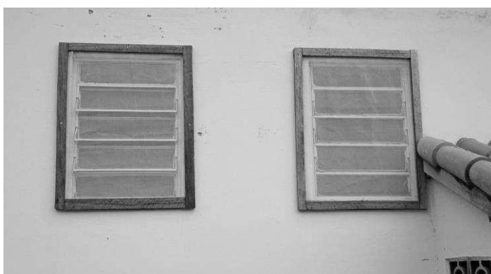
Foto: janelas dos apartamentos/chalés com a devida tela de proteção
