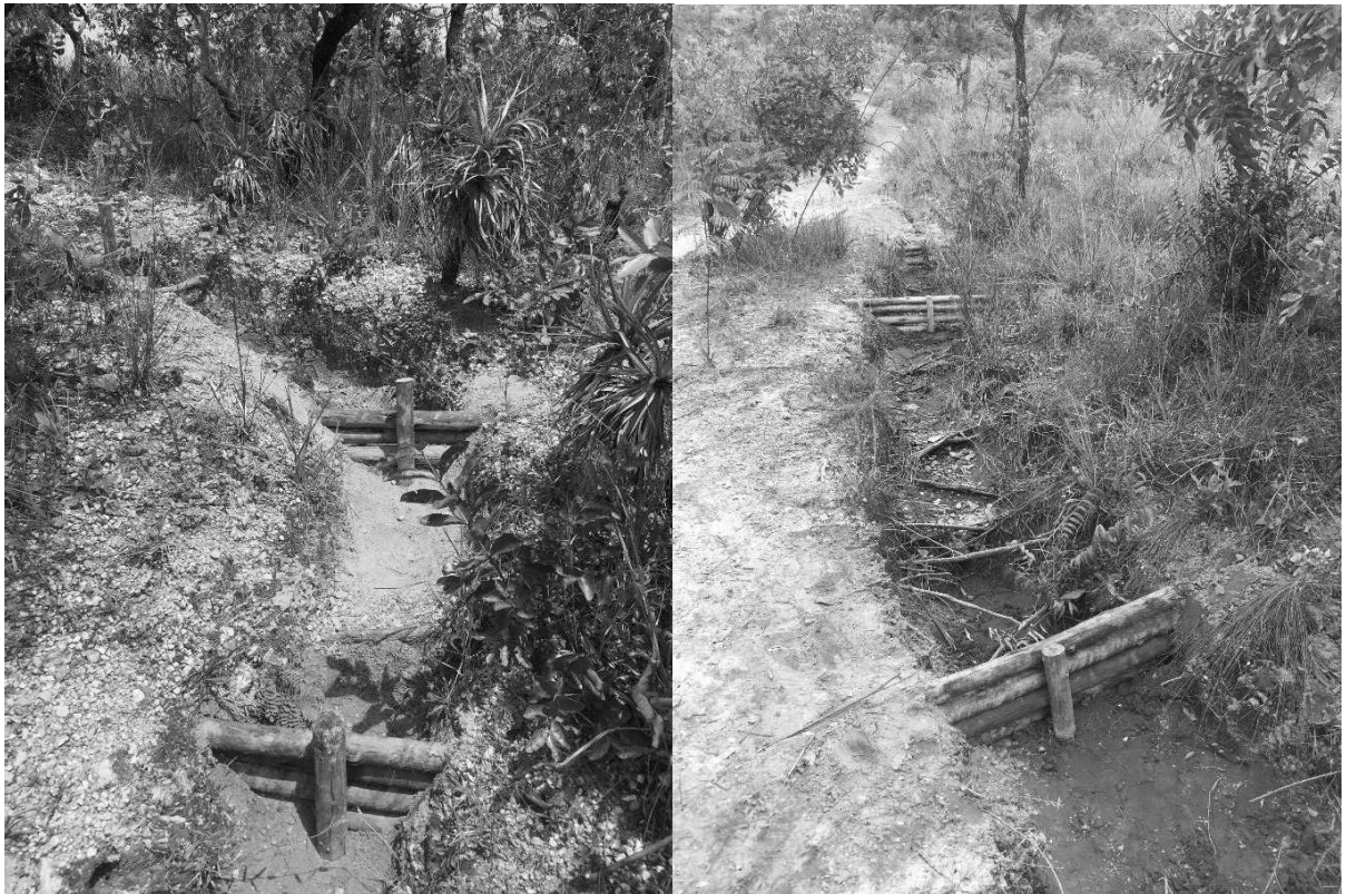
Foto: implantação de paliçadas para contenção de erosões
