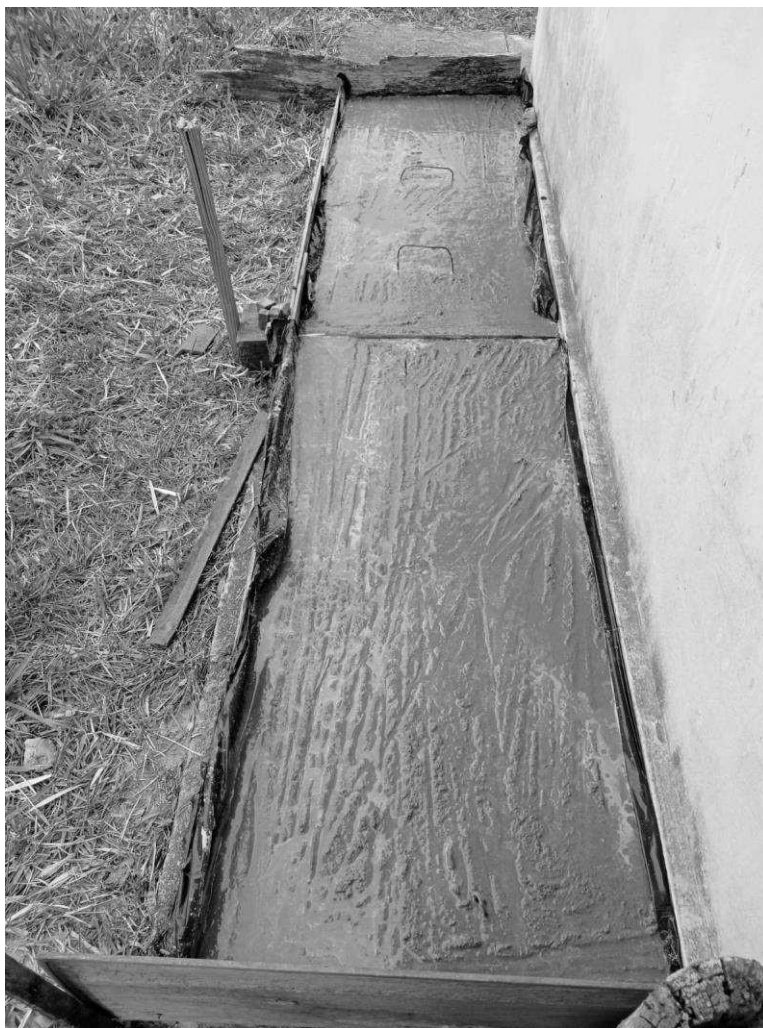
Foto: formação das tampas de cimento
