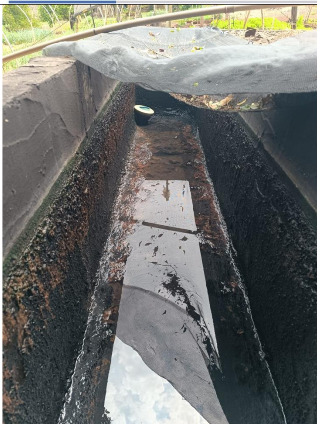
Esgotamento e manutenção da Zona de Raízes da ETE do hangar
