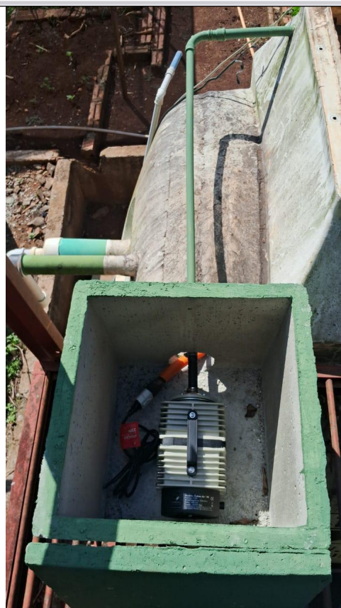
Substituição de bomba da ETE hangar
