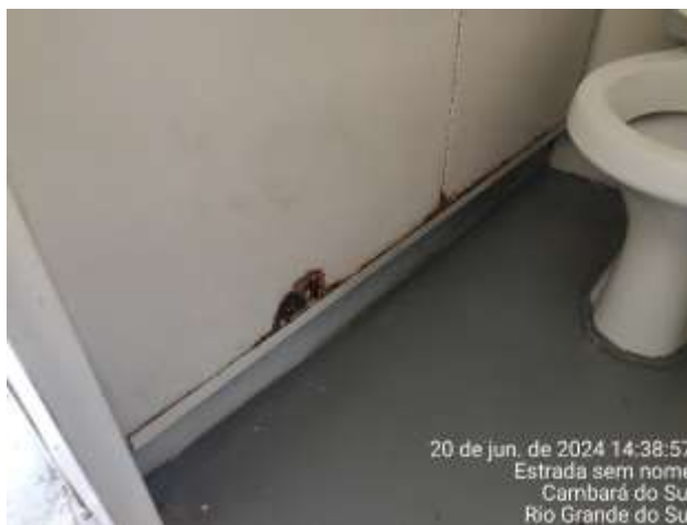
011 – Presença de ferrugem na estrutura do banheiro masculino – Portaria Fortaleza
