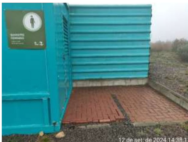
012 – Sem a parede de proteção da porta – PIC Segredo
