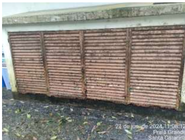
016 – Grades com ferrugem e danificadas – Núcleo Rio do Boi
