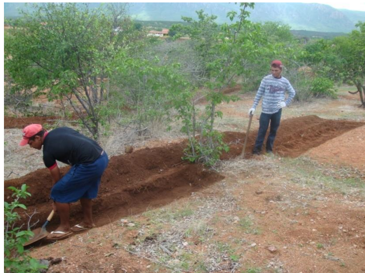
Construção manual de terraços e terraço mecanizado para o manejo de bacias hidrográficas.
