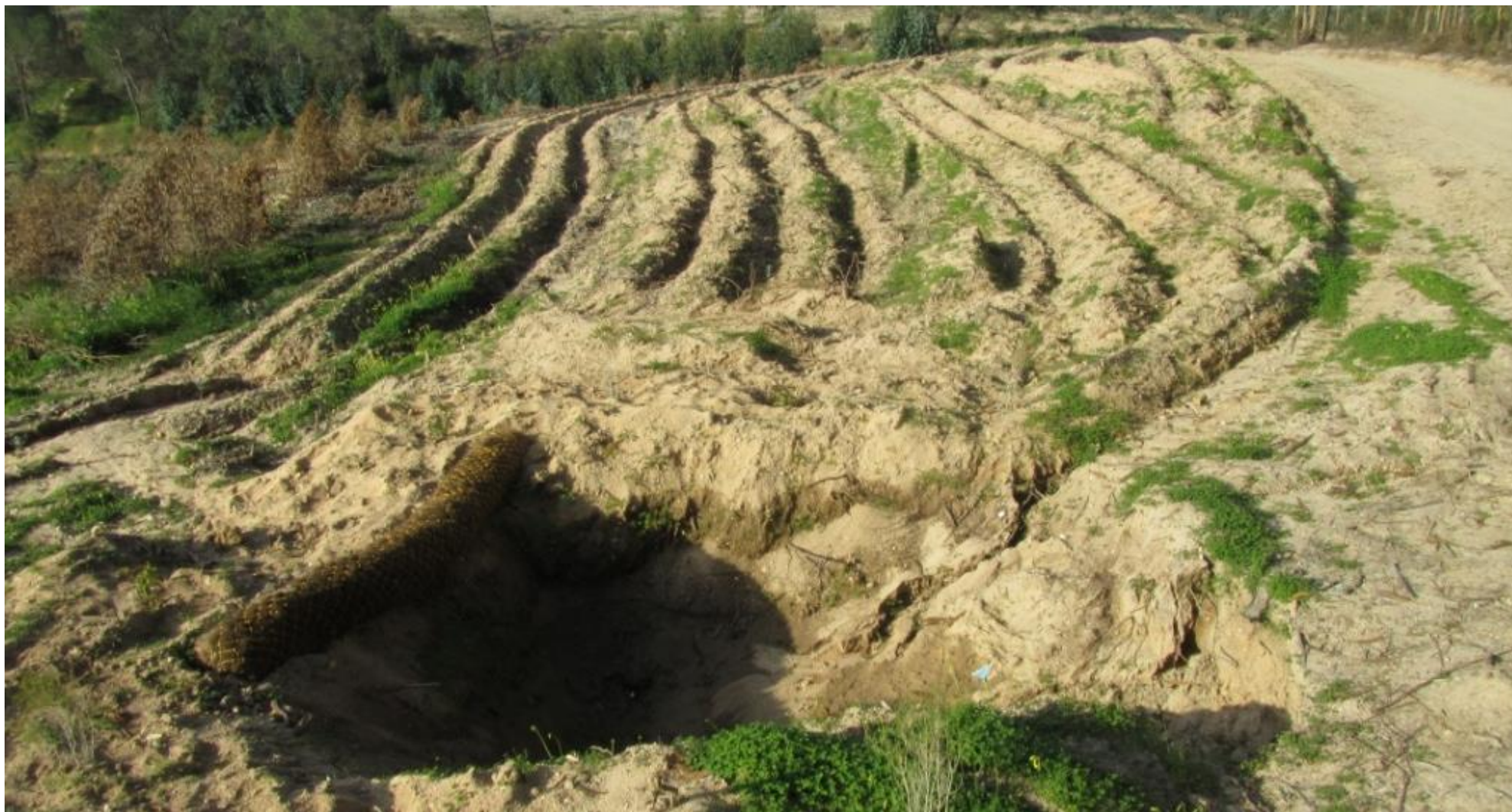
Captação in situ com curvas de nível, para aumento da infiltração, e barragem para armazenamento de água.
