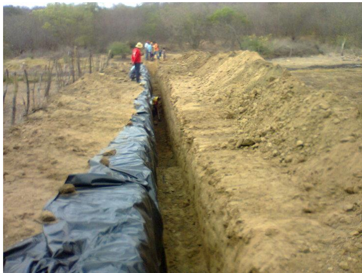
Construção de uma barragem subterrânea utilizando lona plástica para impermeabilização
