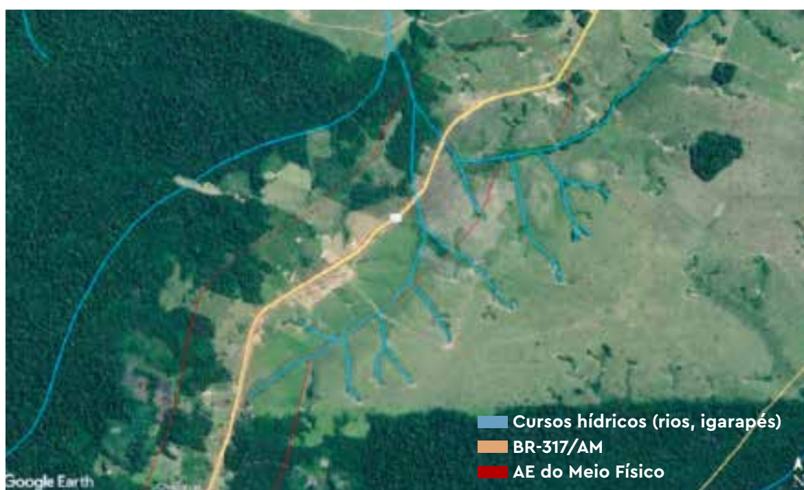
Figura 5.1.5 Imagem aérea demonstrando os principais pontos de interseção (cruzamento) de cursos hídricos com a BR-317/AM ao longo dos trechos a serem pavimentados
