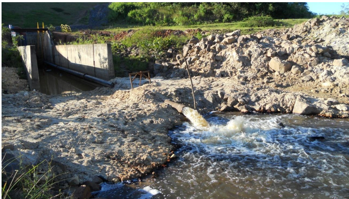
Figura 2.8– Aspecto lançamento da água de fundo da barragem, vazão regular de 0,2\text{m}^3.\text{s}^{-1} . Fonte: o autor.
