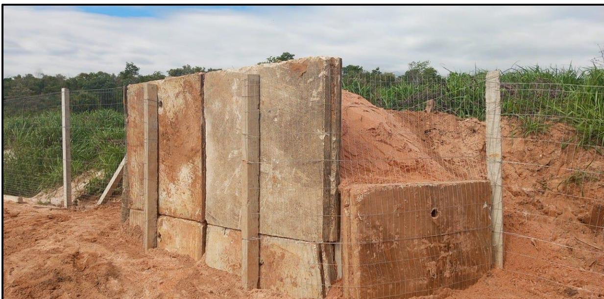
**Figura 8** - Exemplo de jump-out implementado em Rondonópolis/MT (Rumo Malha Norte). Foto: Rumo.
