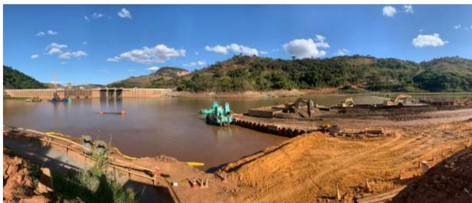
Figura 1 – Dragagem no reservatório da UHE Risoleta Neves.
