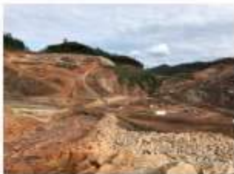
Figura 2: Local de construção do Dique Exo 1
