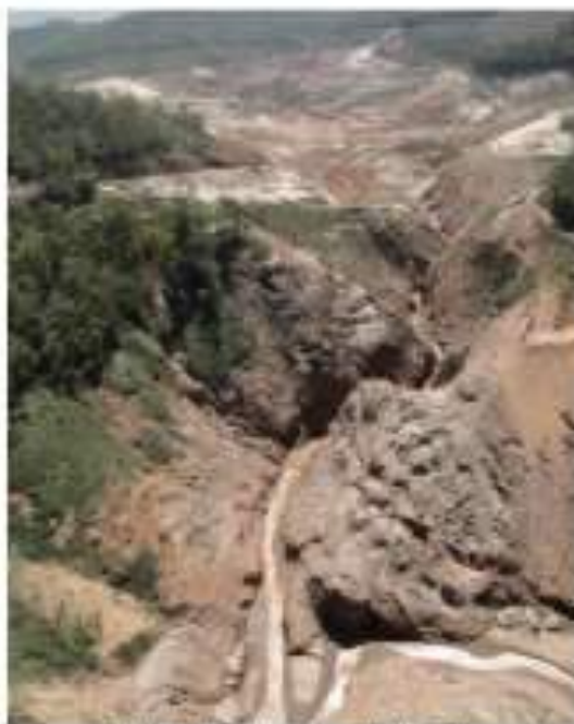
Figura 08: Garganta 1 após o Eixo 1. Fonte: Fundação Renova, 2018
