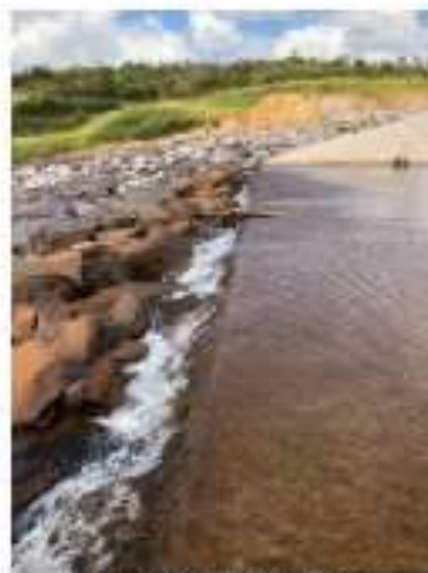
Figura 3: Crista do dique S3
