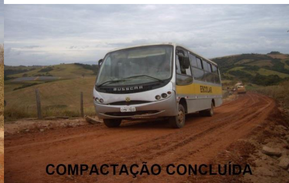
COMPACTAÇÃO DA MISTURA DE BRITA E MATERIAL ARGILOSO
