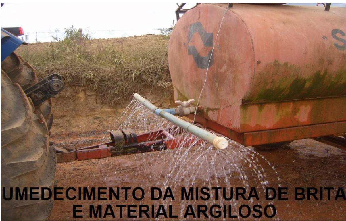
MISTURA DE BRITA NO MATERIAL ARGILOSO
