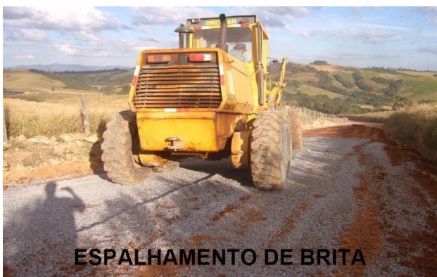
MISTURA DE BRITA NO MATERIAL ARGILOSO
