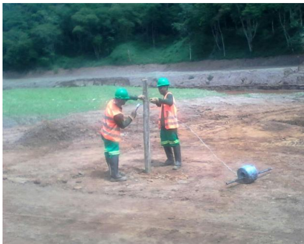
Figura 42: Construção de cerca
