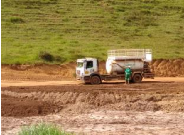
Figura 38: Hidrossemeadura
