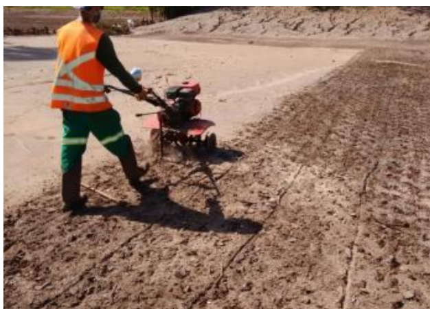
Figura 30: Ecarificação mecânica (Motocultivador)
