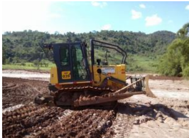
Figura 29: Acerto do solo e escarificação com trator de esteira
