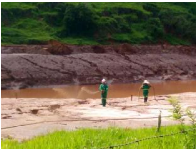
Figura 40: Hidrossemeadura
