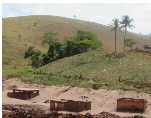
Figura 6: Acúmulo de Lama em área antropizada – Gesteira
