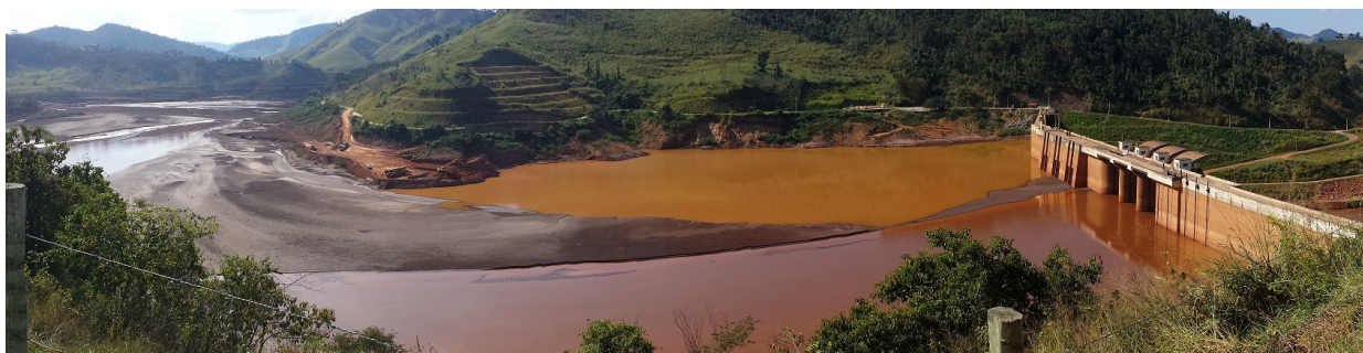
Condição atual da região de interesse
