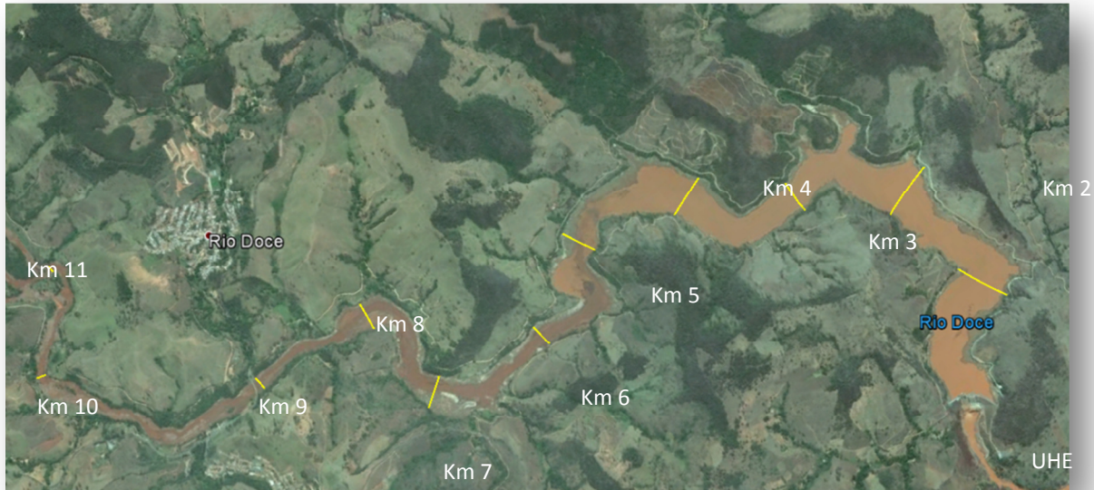
Figura 2 - Vista Geral do Lago
