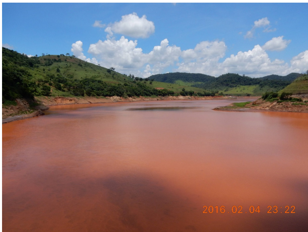
Foto 4 – UHE Risoleta Neves, vista para montante do reservatório.
