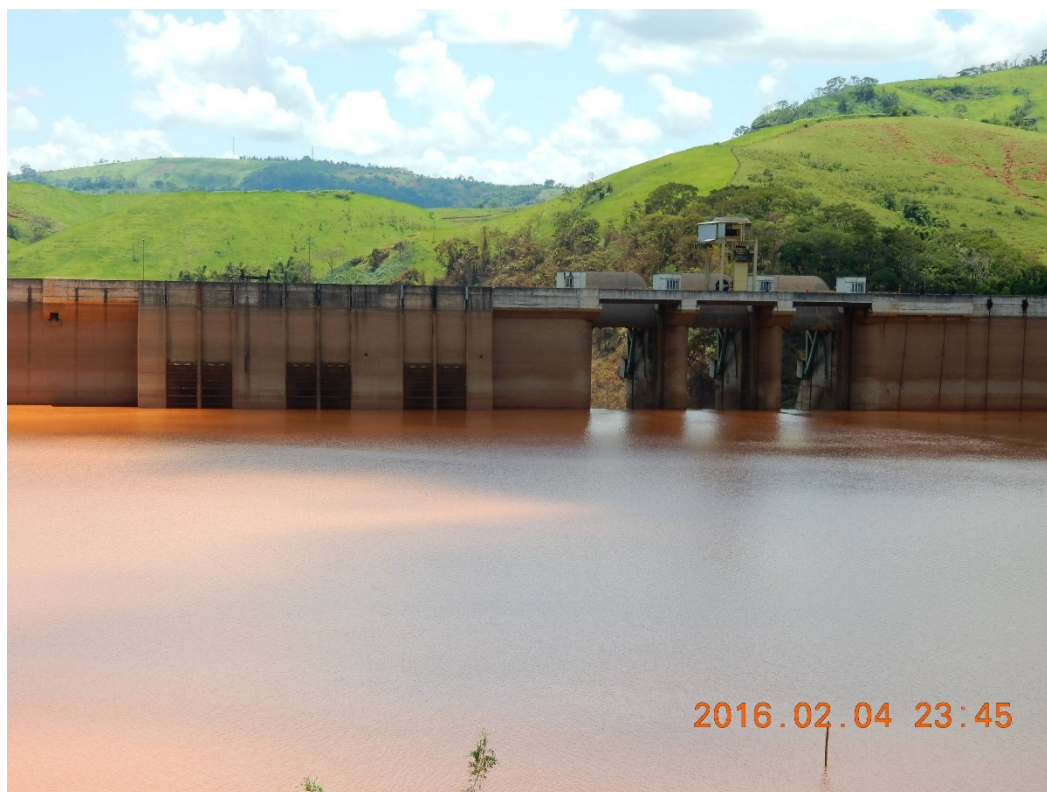
Foto 9 – UHE Risoleta Neves, tomadas d’água para a casa de força e o vertedouro.
