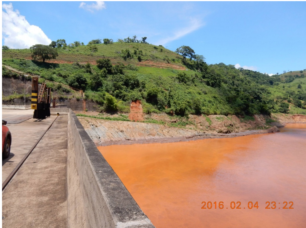
Foto 3 – UHE Risoleta Neves, vista para a margem direita do reservatório.
