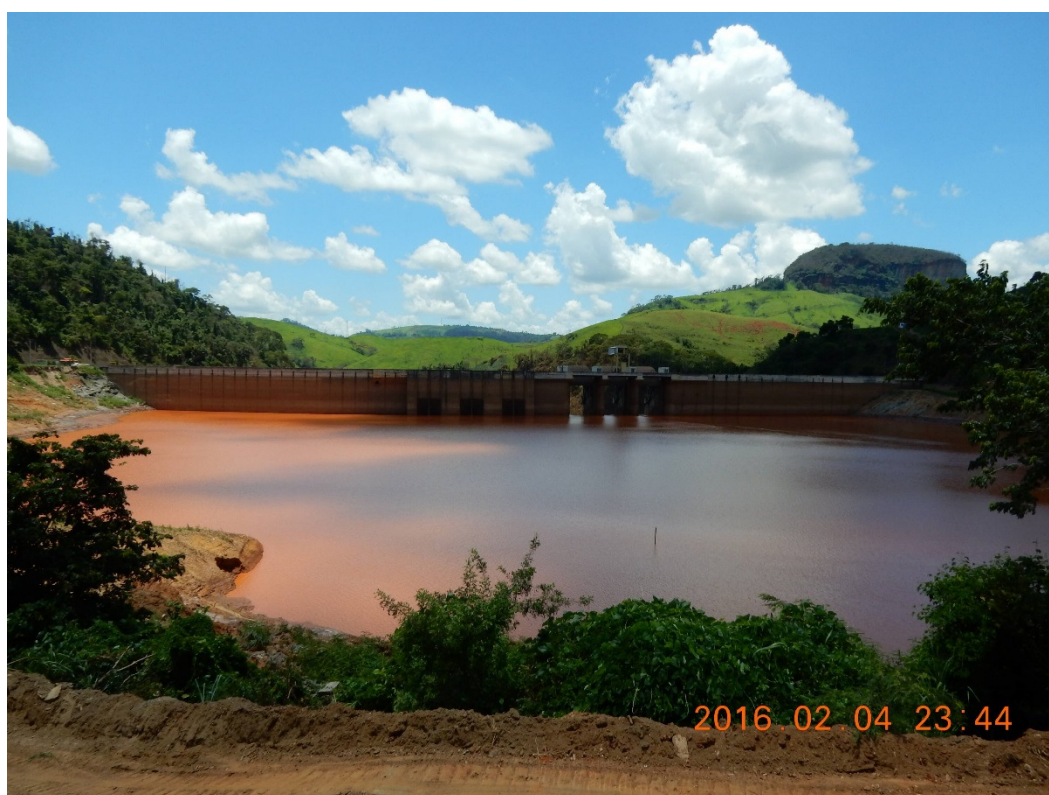
Foto 8 – UHE Risoleta Neves, vista da barragem, a partir de montante
