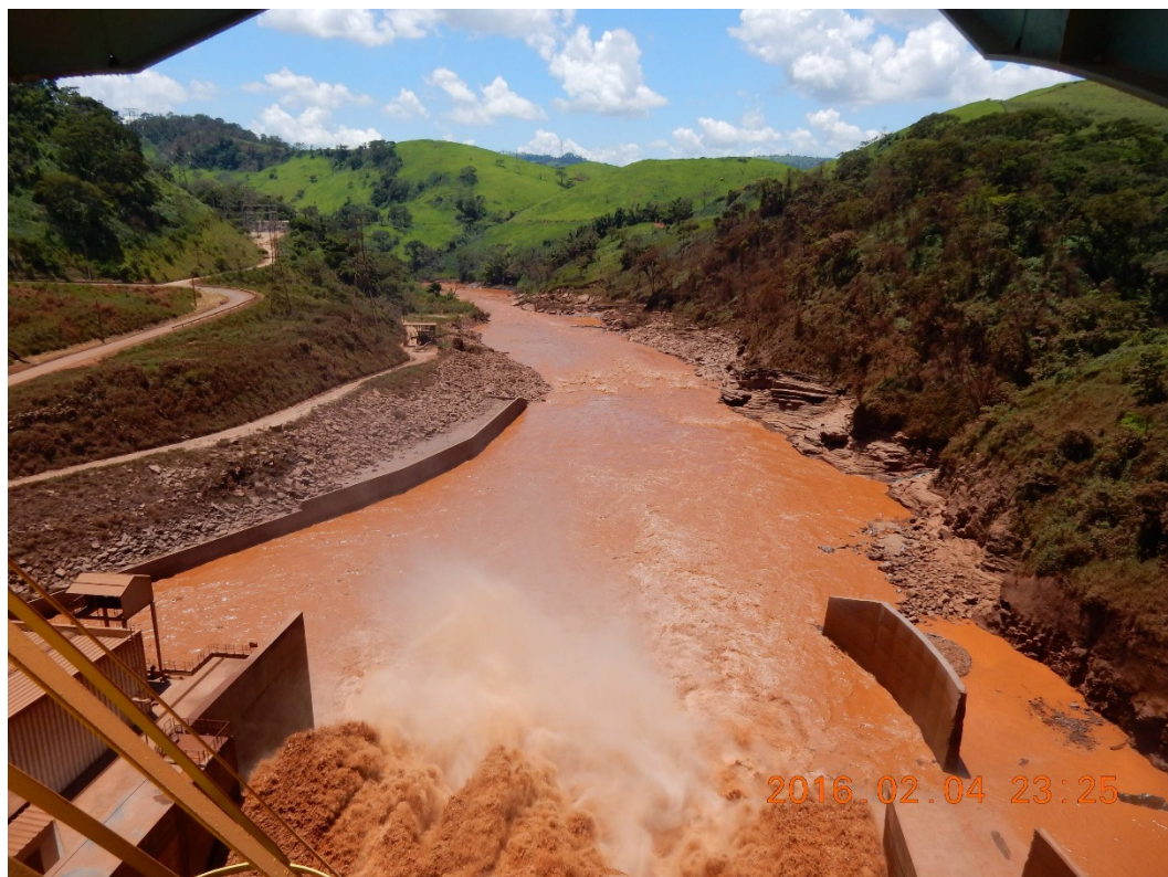
Foto 2 – UHE Risoleta Neves, vista para a jusante.
