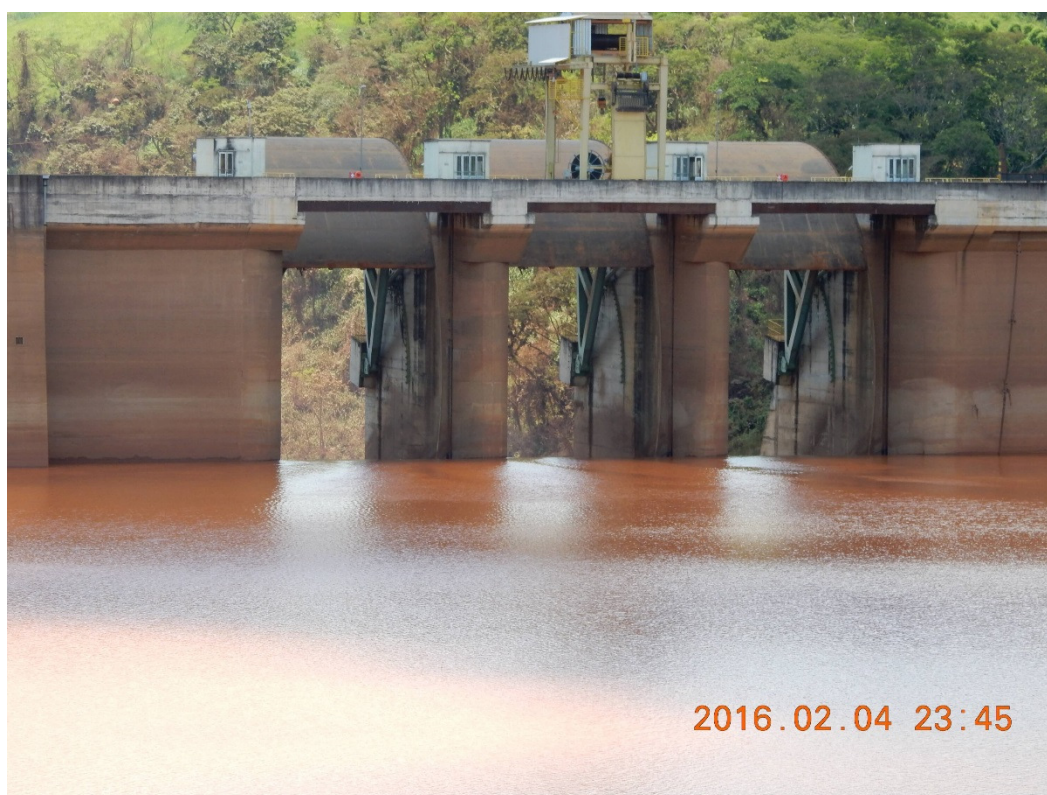
Foto 10 – UHE Risoleta Neves, vista do vertedouro, a partir de montante.
