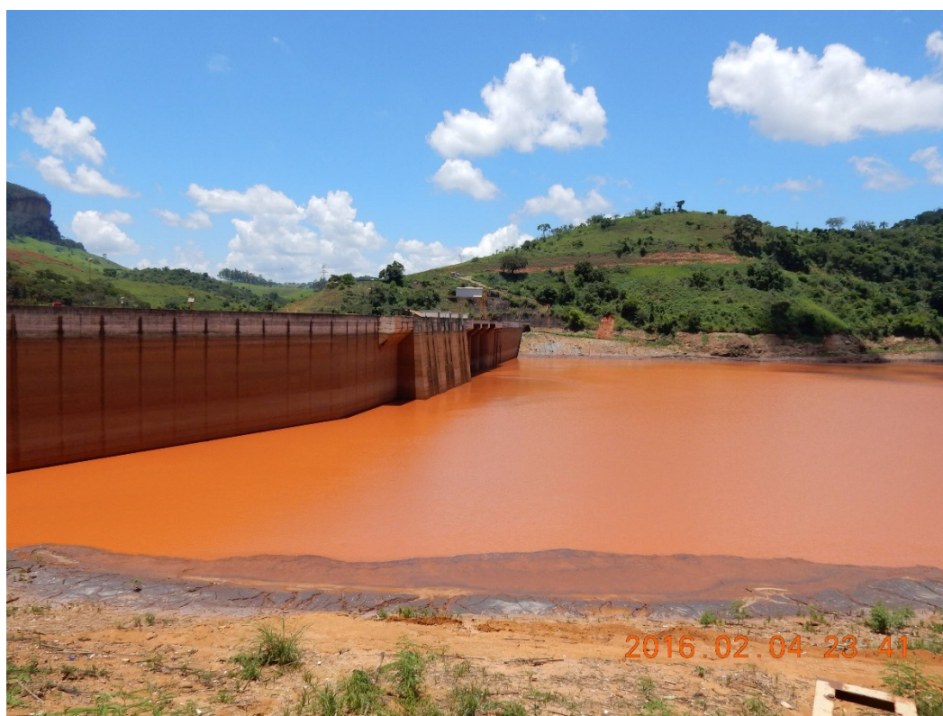
Foto 6 – UHE Risoleta Neves, vista da barragem, a partir da marquém esquerda.
