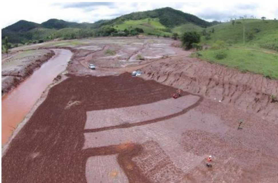
Figura 8: Exemplo 3 - Preparo do solo utilizando métodos manuais e semi mecanizados de escarificação do substrato, sementeira e fertilização.
