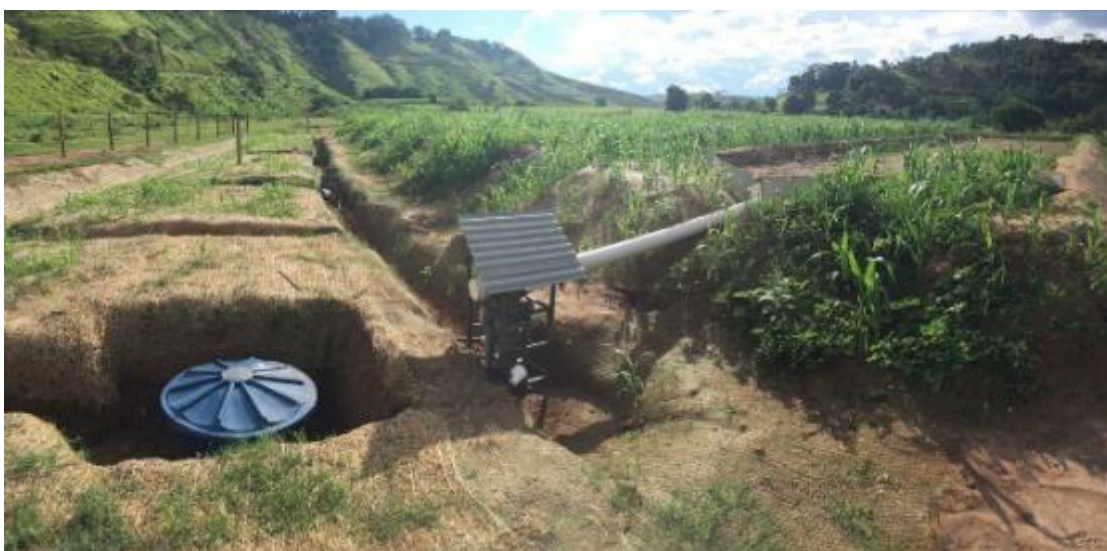
Figura 28: Sistema formado por caçamba basculante e caixa coletora implantado
