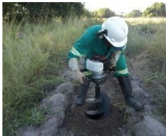
Figura 56: Abertura de cova semi- mecanizada
