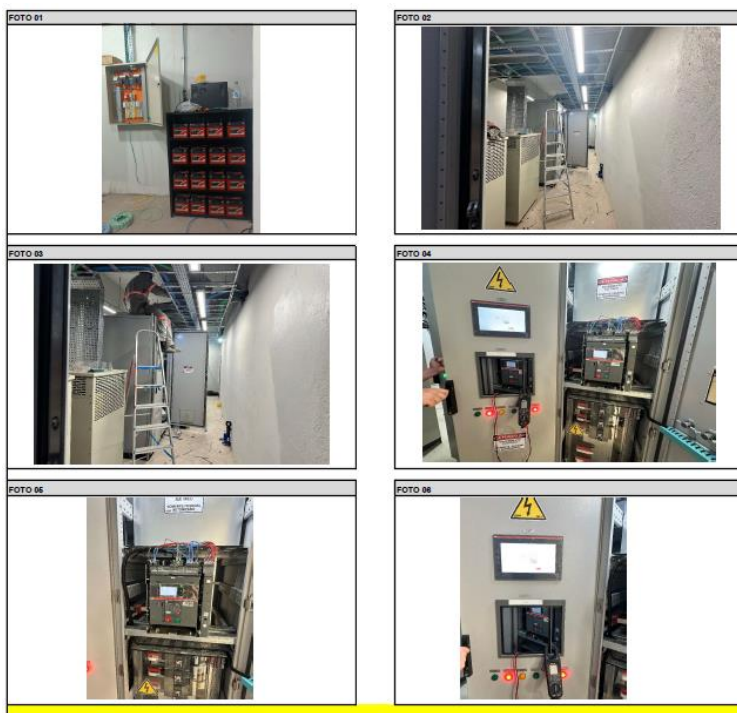
Imagem 8: Reforma da subestação
