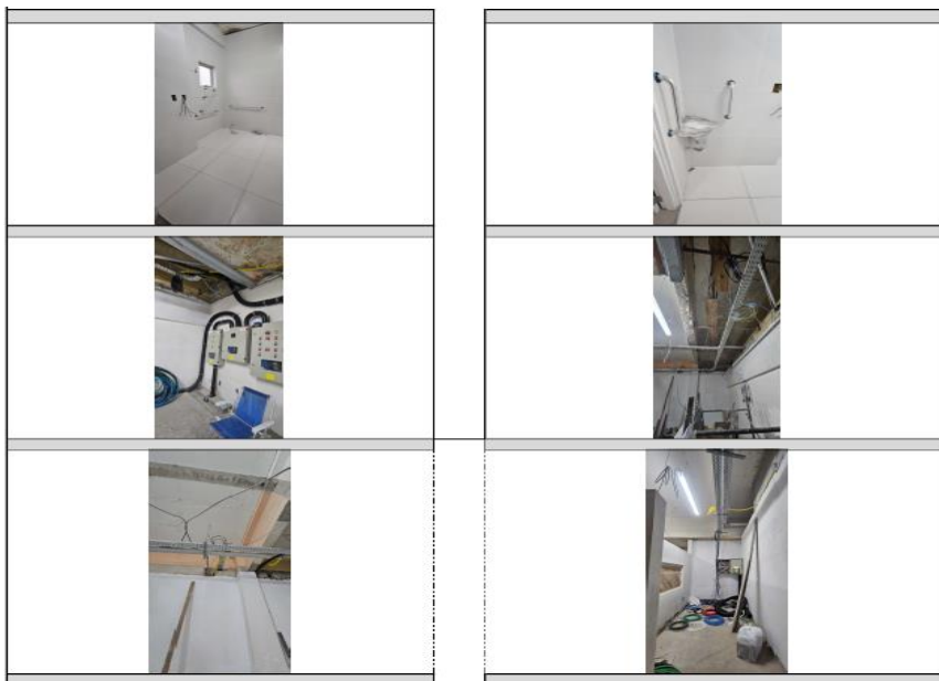
Imagem 9: Obra Sala do raio-x
