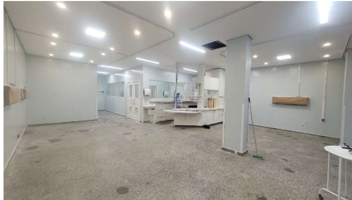
Figura 48: Reforma das Instalações da UTI Adulto
