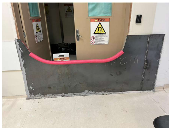
Figura 50: Barreiras internas construídas durante a enchente
