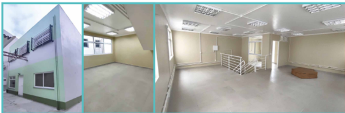
Fachada do novo prédio e salas administrativas
