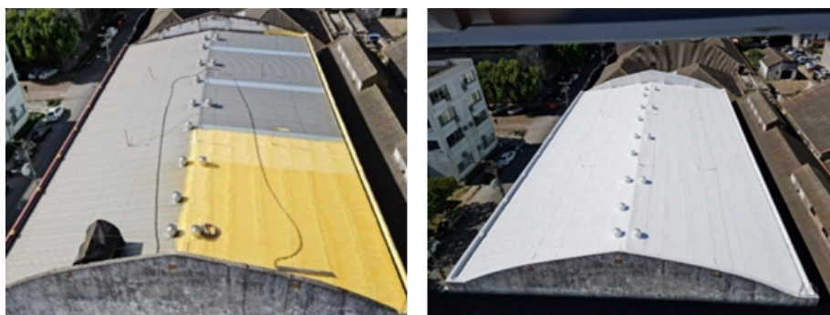
Figura 12. Resultado da aplicação de Isolamento Térmico-Hídrico na Cobertura do Almoxarifado Central
