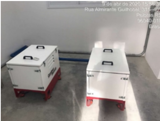
Figura 2. Central de Vácuo Hospitalar
