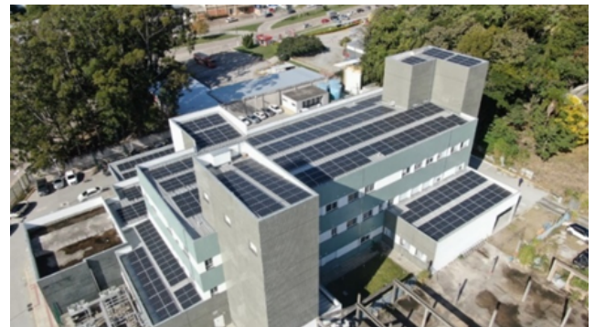
Figura 3. Sistema de geração de energia fotovoltaica
