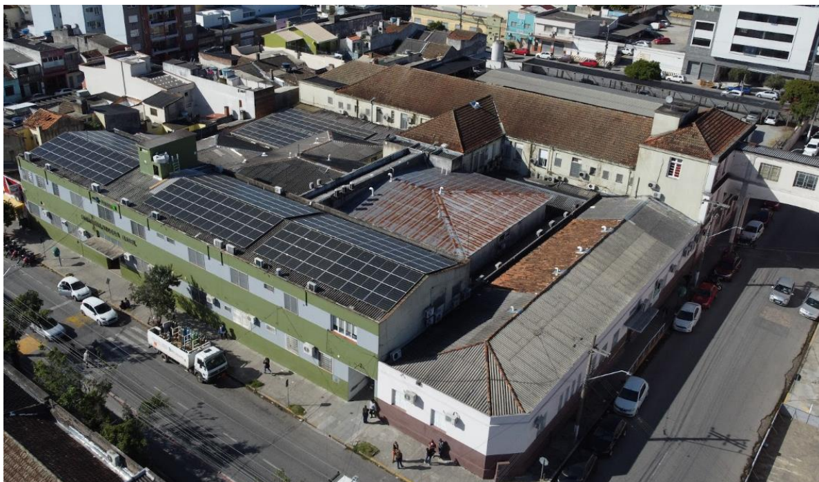
Imagem da cobertura do HE com o sistema instalado
