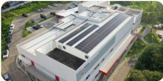
Instalação de usina fotovoltaica no Complexo Ambulatorial Multirreferenciado
