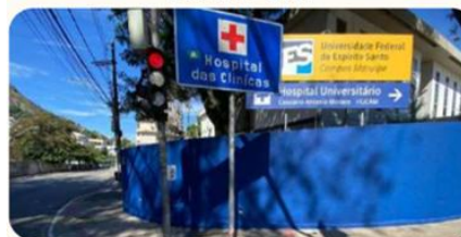
Revitalização do muro externo do Hucam-Ufes
