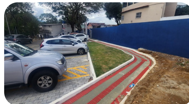
Acessibilidade Complexo Ambulatorial Multirreferenciado
