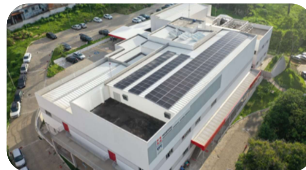
Instalação de usina fotovoltaica no Complexo Ambulatorial Multirreferenciado
