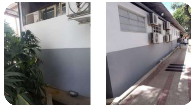
Revitalização da fachada dos ambulatórios (Ambulatórios 01 a 06)
