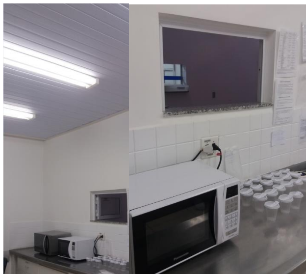
Figura 18 - Copa de manipulação dos alimentos após reforma estrutural
