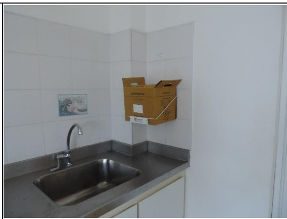
Coletor de perfuro-cortante na sala avaliação física, devido ao armazenamento de medicamentos de oftalmologia no local.
