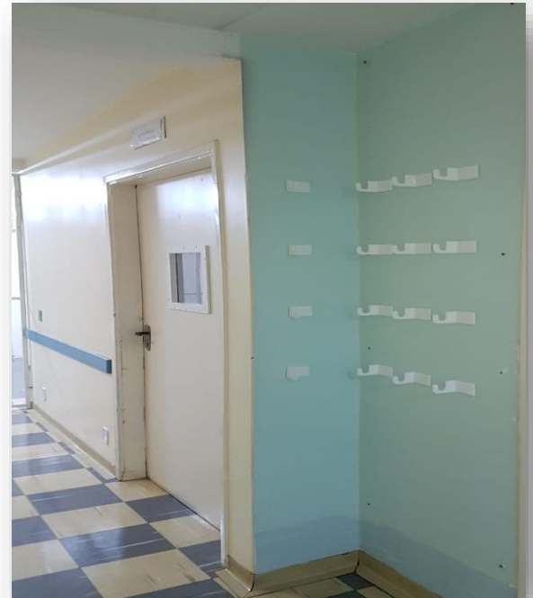
Colocação de visor nas portas para contribuir para assistência segura aos pacientes e instalação de suportes para EPIs.
