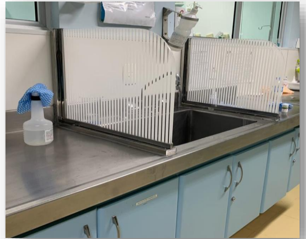
Instalação de barreiras para adequação do espaço utilizado no preparo de medicação, separando área molhada da seca.
