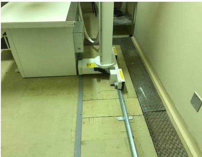
Imagem 18. Detalhe da grelha adaptada para a instalação do novo equipamento de Raio-X
