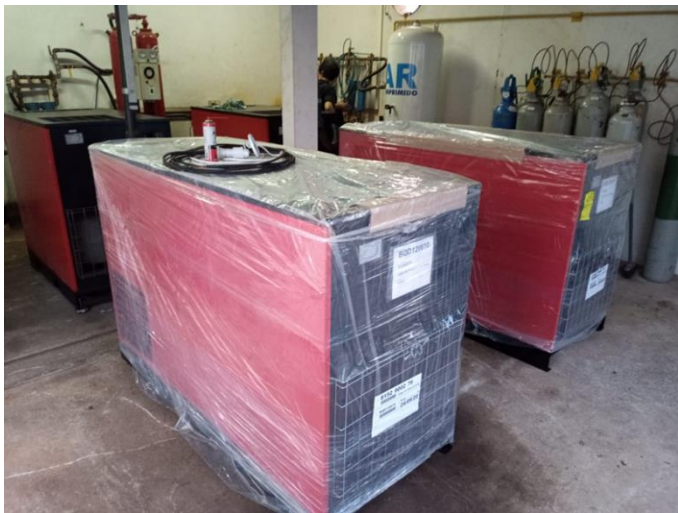
Imagem 3. Chegada dos novos compressores em suas respectivas embalagens
