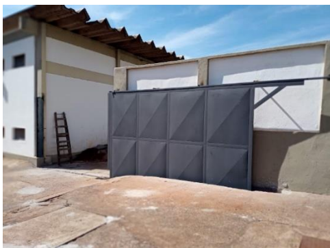
Imagem 35 – Portão da área da caldeira
