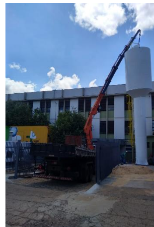
Imagem 34 – Instalação de um reservatório de água
