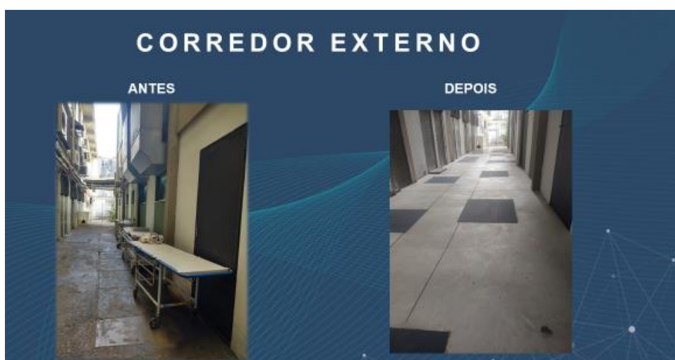
Figura 138 – Imagens do corredor externo do pronto-socorro antes e depois da reforma. Fonte: UUE.
