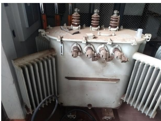
Imagem 6 – Transformadores a seco - Antes
