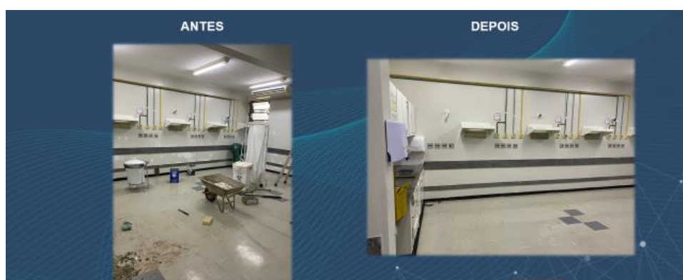
Figura 137 – antes e depois da reforma de uma enfermaria.
