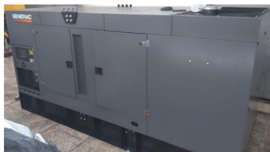
Imagem 5 – Grupo Gerador - Depois
