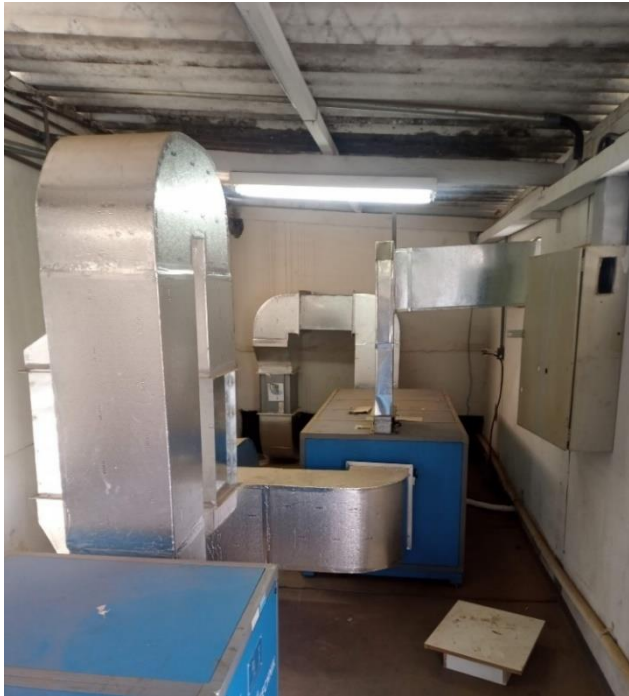
Imagem 6. Instalação dos dutos de refrigeração na casa de máquinas
