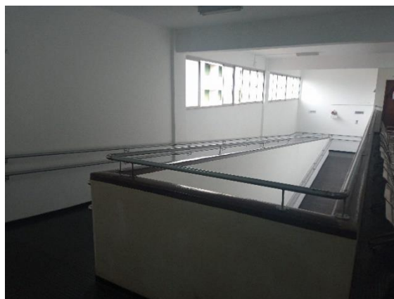
Imagem 21 – Imagem do Centro de Reabilitação revitalizado e modernizado, adaptado às necessidades atuais
