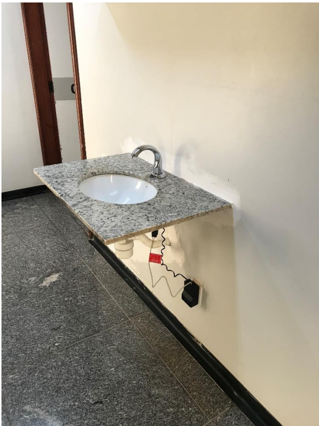
Imagem 14. Detalhe da instalação de uma pia com torneira com acionamento por sensor no segundo pavimento do Hospital da Mulher para criar a área Covid
