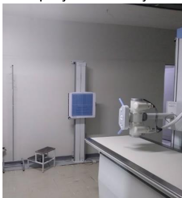
Imagem 41 - Sala para raio X na UUE
