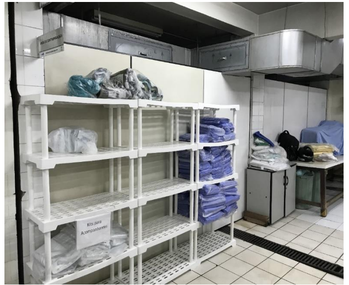
Imagem 23. Visão geral do ambiente de guarda do enxoval limpo, após reforma
