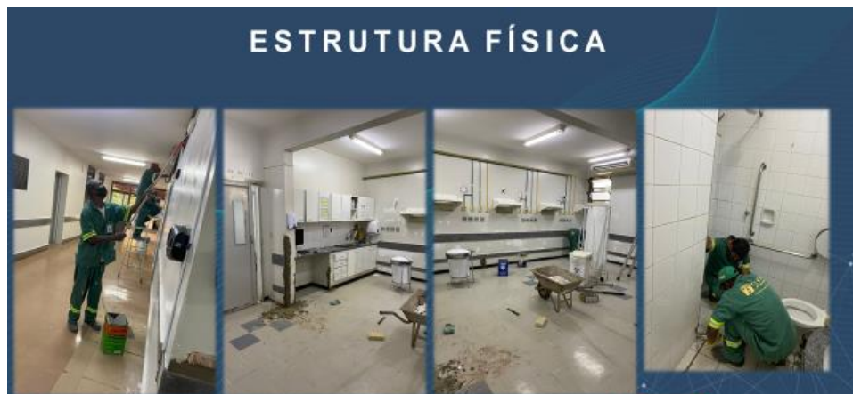
Figura 136 – Reforma estrutural do Pronto Socorro. Fonte: UUE.
