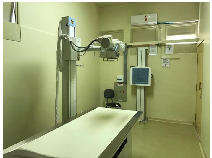
Imagem 19. Visão geral da sala do novo equipamento de Raio-X instalado
