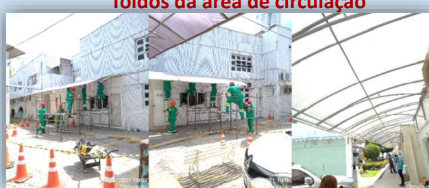
Toldos da área de circulação
