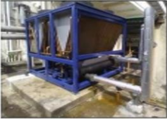
Substituição do chiller – climatização central
