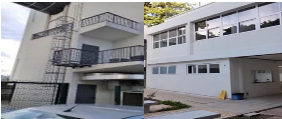
Obra Pronto Atendimento e ambulatório pediátricos
