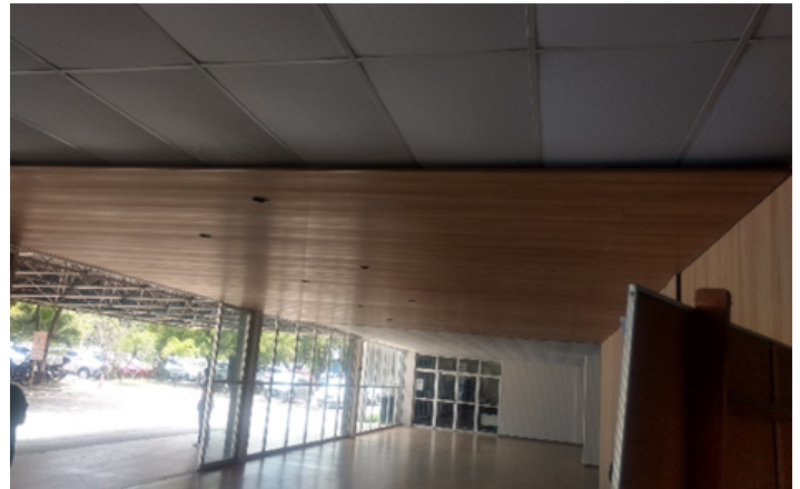
Figura 33. Manutenção do Hall de Acesso principal – Ano 2021
