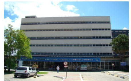
Figura 3. Fachada do HUPAA
