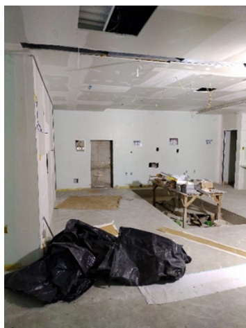
Figura 36. Reforma do Bunker da Radioterapia para substituição do acelerador linear – Ano 2022
