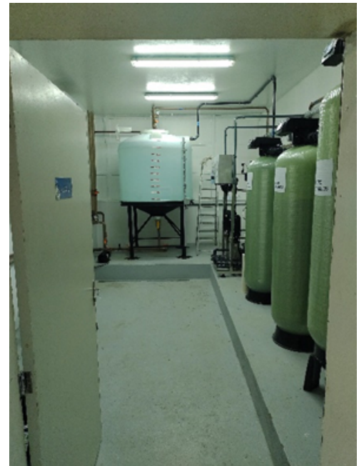
Figura 41. Substituição do sistema de tratamento de água de hemodiálise - Ano 2022
