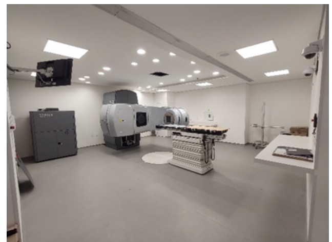
Figura 37. Bunker do Acelerador linear – Ano 2022
