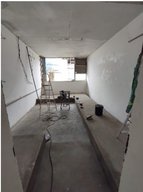
Figura 40. Substituição do sistema de tratamento de água de hemodiálise - Ano 2022
